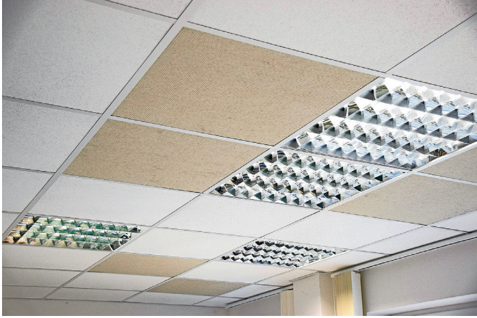
Zwei mögliche Ansichten von Naturfaser-Composites: Deckenrasterplatte (oben), unterschiedliche Oberflächenstrukturen (re.)
